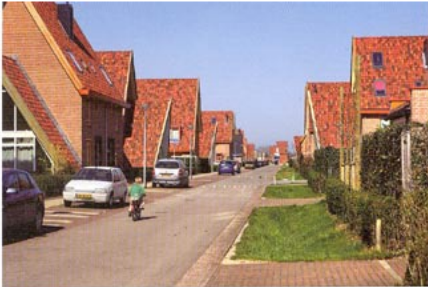
Woonstraat met twee-onder-een-kapwoningen.
